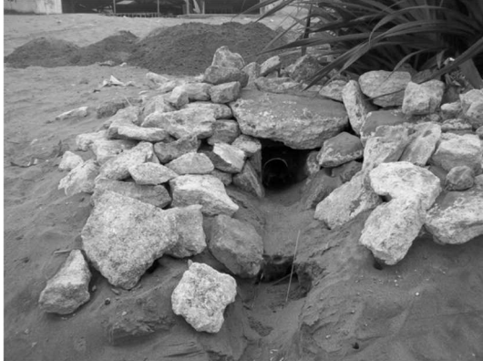
Gambar 1. Sistem pembuangan yang ada di salah satu warga di Pantai Depok
