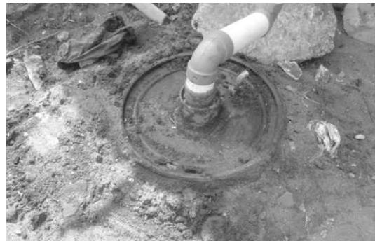
Gambar 10. Bak digester yang sudah ditanam.
