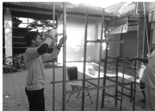
Gambar 4. Pembuatan instalasi pengolahan limbah toilet umum sesuai hasil pemeriksaan laboratorium.
